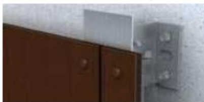
Skryté připevnění pomocí kolíků
